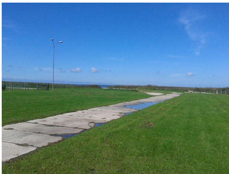
Rysunek 31. Przystań Suchacz Cegielnia. Do odtworzonej przystani (w tle) prowadzi utwardzona płytami betonowymi droga dojazdowa. Stan z sierpnia 2016
