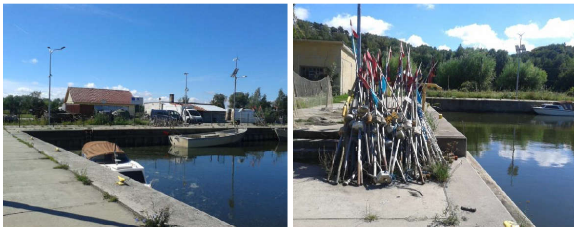
Rysunek 36. Przystań Suchacz. Nabrzeże Zachodnie ze stanowiskami dla rybaków. W tle widoczne zabudowania zaplecza rybackiego (zdjęcie po lewej). Nabrzeże Wschodnie dedykowane działalności rybaków. Widoczny uskok nabrzeża powstały po jego przebudowie i podniesieniu rzędnej (zdjęcie po prawej). Stan z sierpnia 2016
