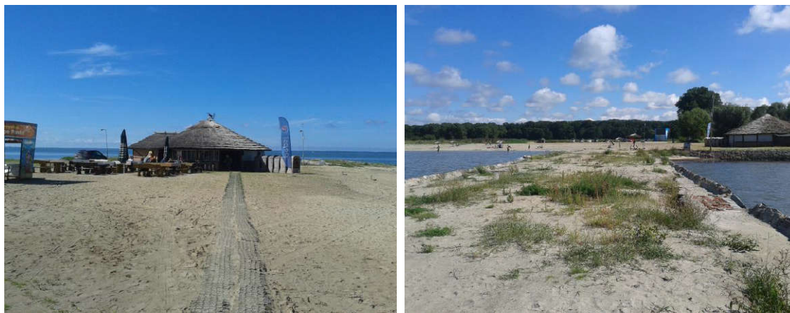
Rysunek 39. Przystań Kadyny. Po lewej budynek tymczasowy o funkcji turystycznej na plaży w Kadynach. Po prawej falochron Wschodni przystani – widoczny brak nawierzchni na konstrukcji. W tle atrakcja turystyczna Kadyn – plaża „Srebrna Riviera”. Stan z sierpnia 2016.
