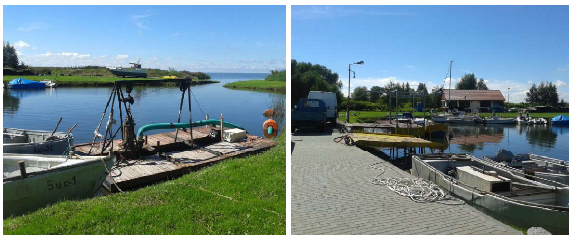
Rysunek 25. Wejście do przystani Suchacz II (po lewej). Nawierzchnia nabrzeża południowego przystani Marita (po prawej). W tle widoczne pomosty pływające i budynek sanitariatów. Stan z sierpnia 2016
