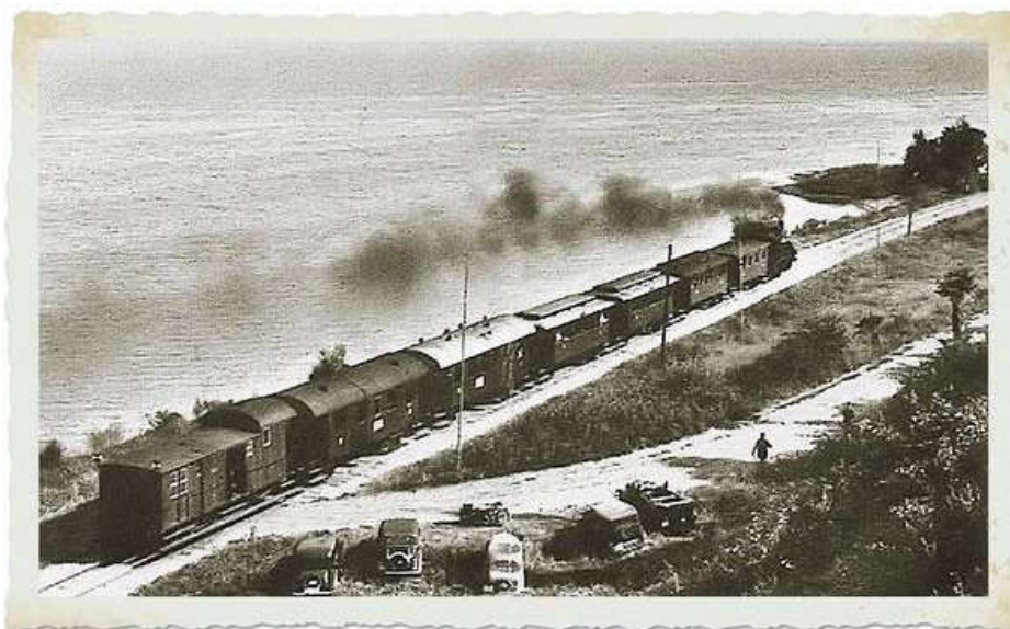
Rysunek 77. Pociąg kolej nadzalewowej (Haffuferbahn)
