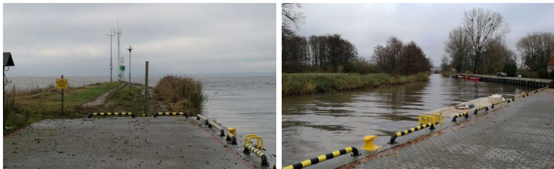
Rysunek 73. Ujście rzeki Pasłęki (po prawej widoczny częściowo zanurzony falochron wschodni) oraz przystań Ujście (po prawej). Stan z października 2016
